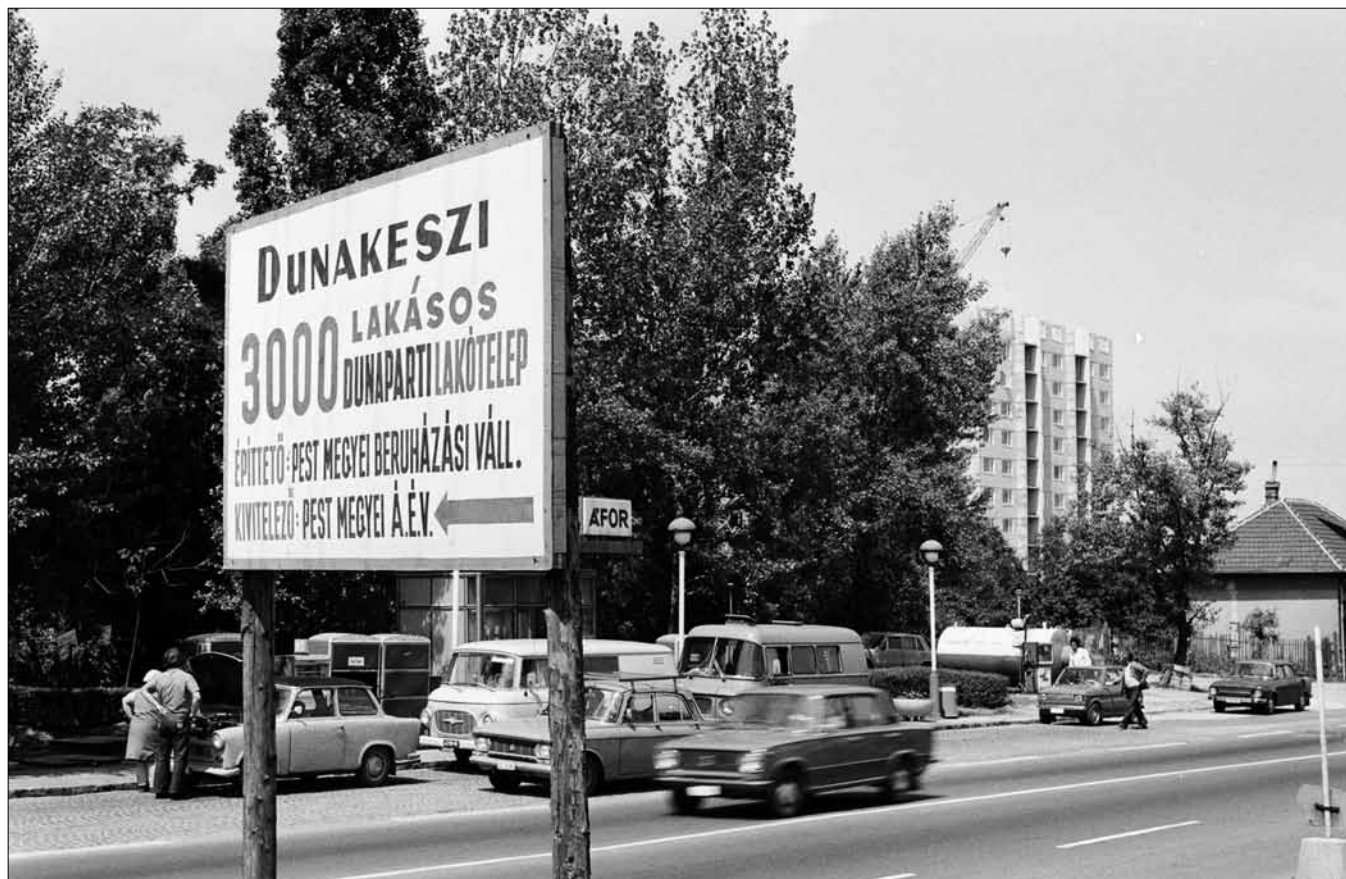
A Fő úton tábla hirdeti a „Dunaparti”, ma Barátság úti lakótelep építését. Az út túloldalán az 1961-ben átadott (még ma is üzemelő) benzinkút látható. A háttérben a Barátság útja 3. számú ház legfelső szintjeinek panelelemt emeli be a daru.
