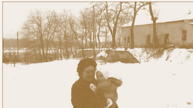
A csárda épülete 1969-ben
